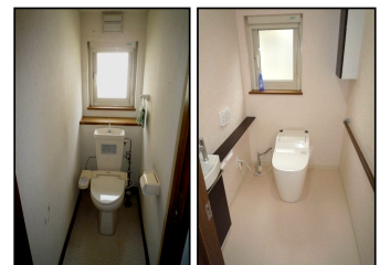
トイレ交換・クッションフロア張替 クロス貼替 ¥149,000~
